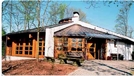
Das Seminargebäude im »Haus Sudetenland« in Waldkraiburg. Fotos: privat
