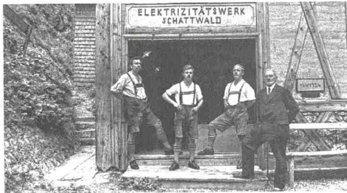
Stolz präsentierte sich Ing. Hohenrainer (r.) mit Maschinisten des KW Vilsfall, das von 1919 bis 1924 als erste Anlage erbaut wurde. Foto: EW Schattwald
